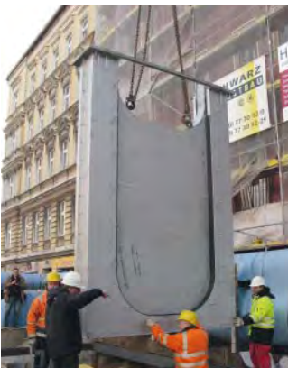
Einbau eines Wehres in der Kanalisation Installation of a weir into the sewer system
