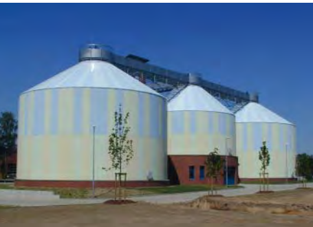
3 parallele Gärreaktoren am Klärwerk Steinhof in Braunschweig 3 parallel digestion reactors of WWTP Steinhof in Braunschweig
