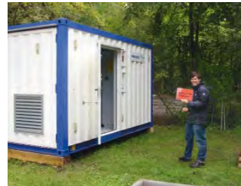
Ozonierungsanlage Tegeler See Pilot-scale ozonation unit at Lake Tegeler
