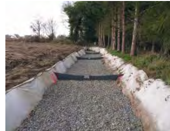
Pilotanlage in der Bretagne Pilot buffer zones in Brittany, France
