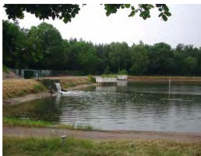
Infiltrationsbecken Tegeler Infiltration pond Tegeler
